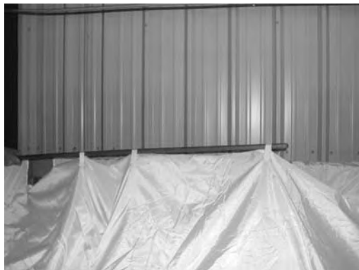
Abb.: Befestigung des Silodeckels
